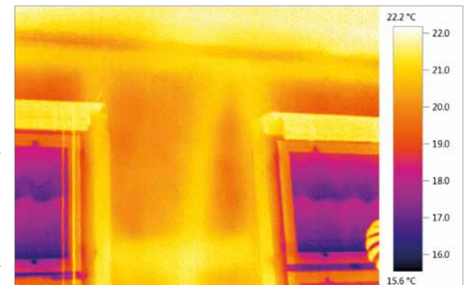
Thermographie du mur extérieur : thermographie d'un mur à ossature avant l'assainissement
