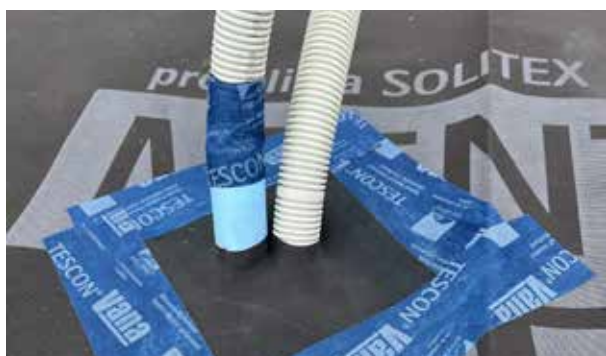
Les manchettes pro clima (adaptées au support) et le ruban adhésif universel TESCON VANA ont été utilisés pour réaliser l'étanchéité de gaines (ROFLEX) ...
