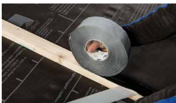
Le ruban TESCON NAIDECK sert de taquet d'étanchéité entre les contre-lattes ...
