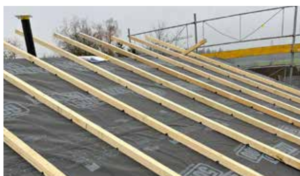
... et l'écran de sous-toiture SOLITEX MENTO 5000 connect.
