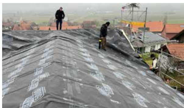
Bâche en SOLITEX MENTO 5000 connect mise en place.
