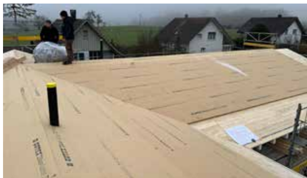
Livraison de la bâche pré-confectionnée pour une pose sur des panneaux de sous-toiture en fibre de bois.
