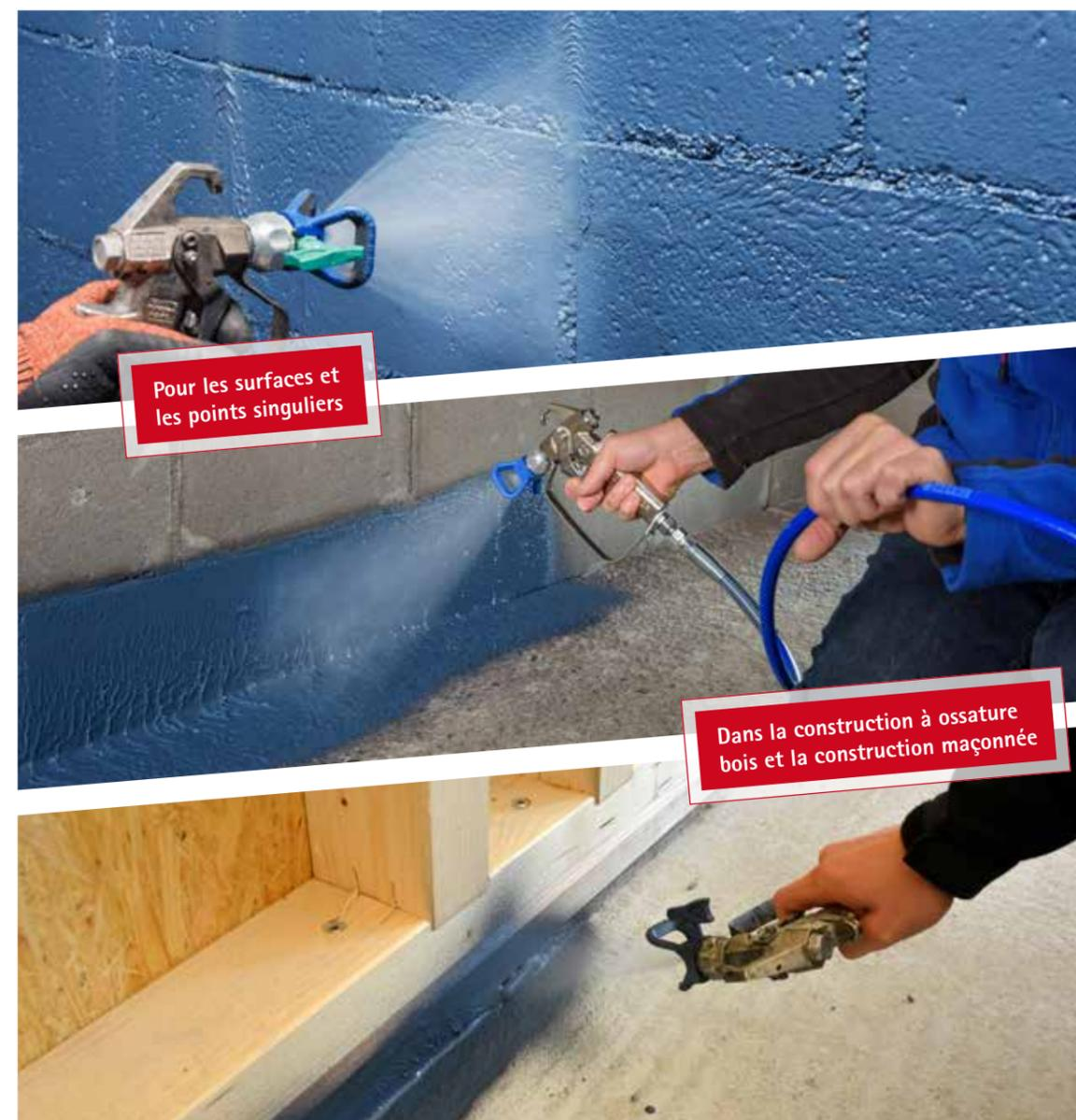
Applicable au pinceau et au pistolet, le produit d'étanchéité à l'air hygrovariable AEROSANA VISCONN vous permet une réalisation extrêmement rapide : aussi bien en surface, comme par exemple sur la maçonnerie non enduite ou les panneaux en matériaux poreux, que pour les raccords entre éléments de construction dans la construction à ossature bois et les constructions maçonnées.
